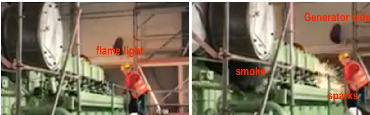
Laut Analyse von Mario Zadra hatte der Stator dieses Notstrom-Generators bereits bei einem früheren Test einen Kurzschluss – aber offenkundig wollten die bauführenden Ingenieure ihn nicht reparieren lassen und versuchten ihn dennoch in Betrieb zu nehmen.
