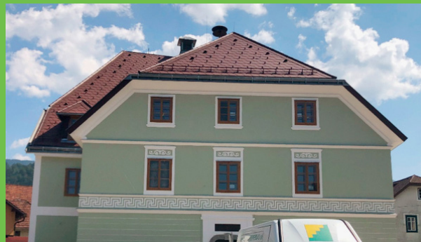
Das denkmalgeschützte Rathaus in Hollenstein (NÖ) wurde einer Mustersanierung unterzogen und wird nun mittels zweier Wärmepumpen beheizt. Bildquelle: Baumeister Ing. Erwin Hackl
