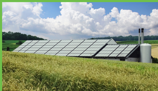
In Poysbrunn (NÖ) liefern 624 m 2 Kollektorfläche auf dem Heizwerkdach 220 MWh/a solarthermischen Energiezuschuss. Anlagen mit über 5.000 m 2 Kollektorfläche gibt es in Friesach (Ktn.) oder Mürzzuschlag (Stmk.). Bildquelle: Gasokol
