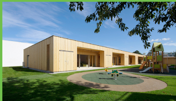
In Deutsch-Wagram (NÖ) wurde ein Kindergarten in Holz-Massiv-Bauweise und Passivhaus-Standard errichtet. Eine Wärmepumpe mit Tiefenbohrungen liefert die nötige Heizenergie. Foto: Juri Troy
