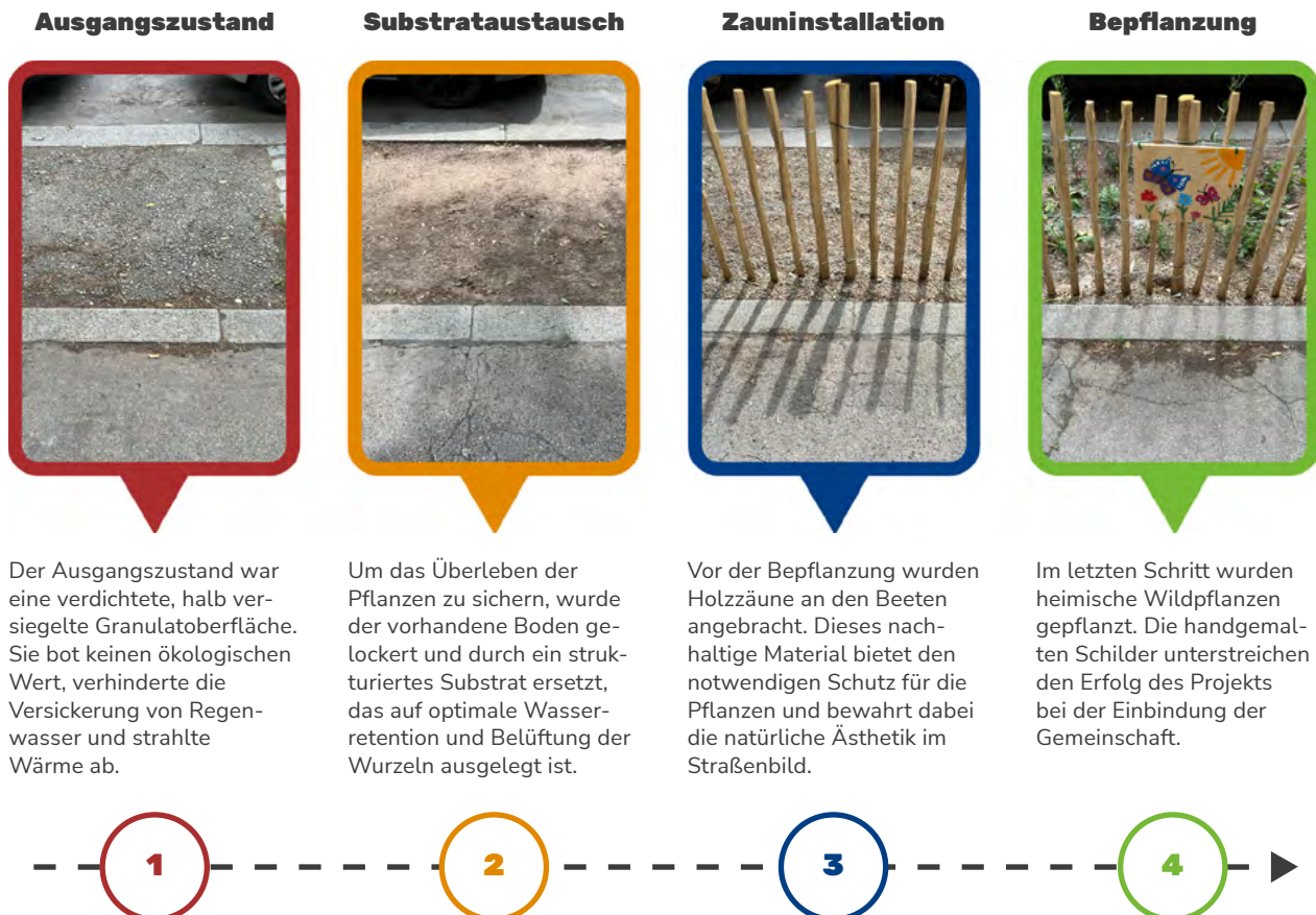
Abbildung 9: Fortschrittsstufen bei der Anlage der Blumenbeete in der Jägerstraße
