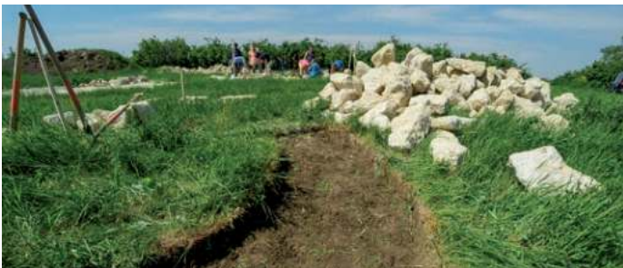
Fundament und professioneller Aufbau einer Trockensteinmauer.
