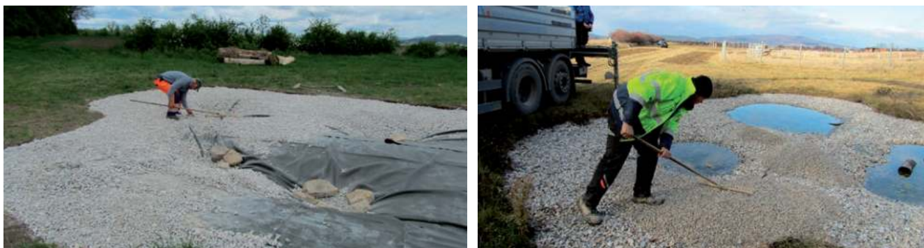
Bau eines Teichs. Der Teich wird mit Teichfolie abgedichtet.
