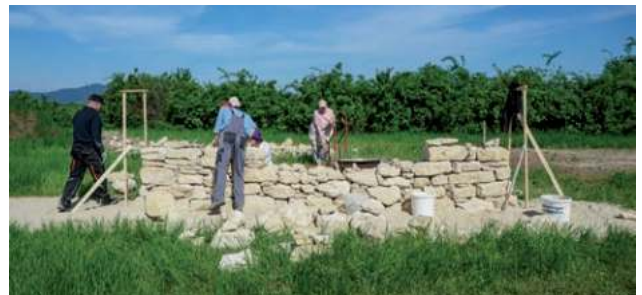
Fundament und professioneller Aufbau einer Trockensteinmauer.
